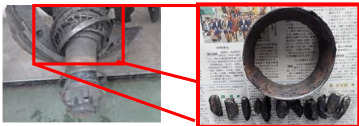
ハブ・ベアリング 破損
