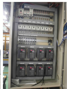
ルーフファン制御盤(インバータ化)
