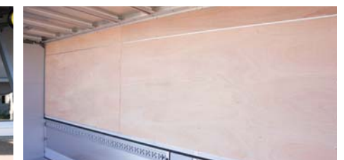
内張り (サイド耐水ベニヤ)
